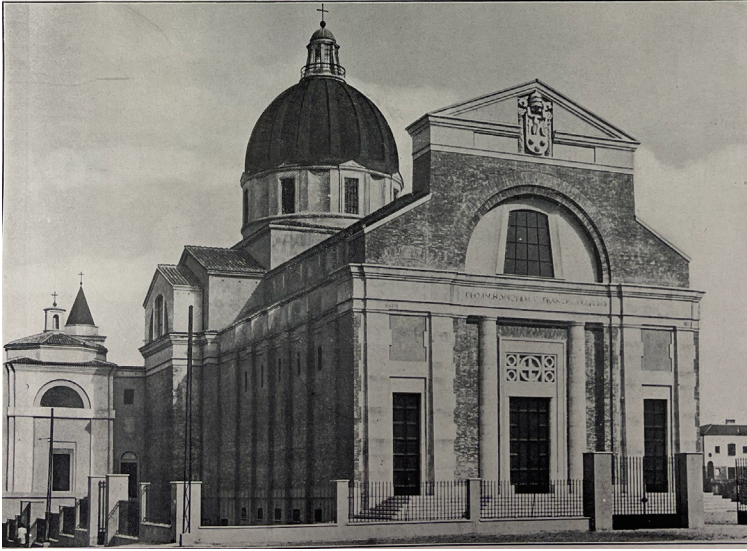
Fig. 5. Roma, chiesa di San Francesco Saverio alla Garbatella, architetti Alberto Calza Bini/Clemente Busiri Vici (1931-1933). Foto in Pontificia Opera per la Preservazione della Fede e la provvista di nuove Chiese in Roma, 5 agosto 1930-31 dicembre 1938, Tipografia Editrice Sallustiana, s.d., copia a stampa conservata presso l'Archivio Storico del Vicariato di Roma, tavola 6.
